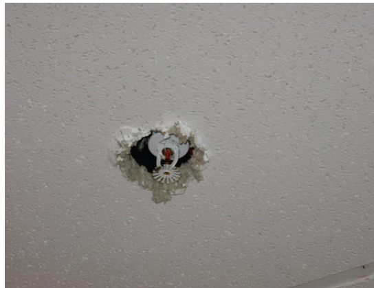
איור 7-6.4.1.1 – דוגמה להתנגשות בין יחידות מתזי המים לסוגים שונים של גימורי תקרה אשר הובילו לנזק בתקרה ובמתלים ולנזקי רטיבות בשדה תעופה.
