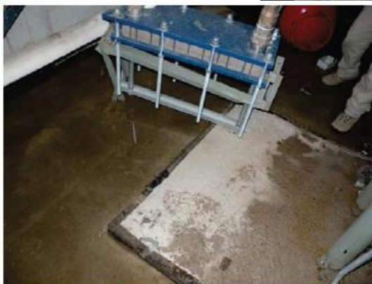
איור 6.4.5.2-1 – שבר בצנרת נחושת להעברת מים חמים. הכשל נגרם עקב תזוזת דוד החימום המוצג מצד שמאל.
