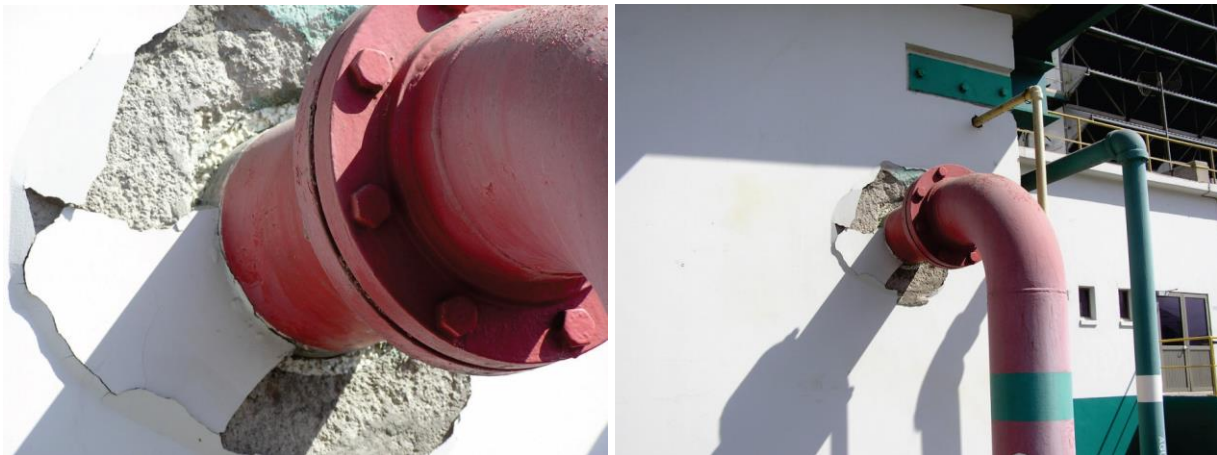
איור 6.4.3.8-2 – נזק שנגרם לטיח סטוקו חיצוני באזור חדירת צנרת כיבוי אש.
