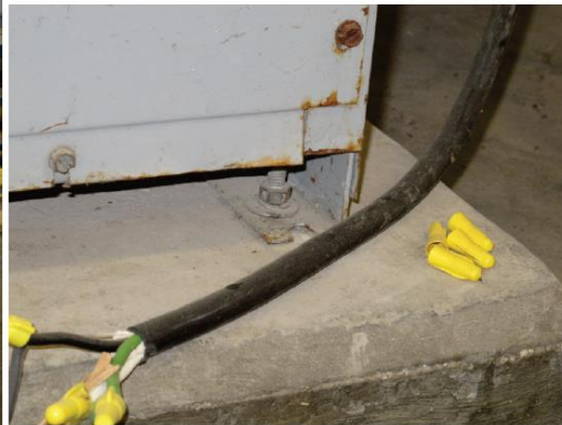
איור 2-6.4.7.3 – שנאי מפצל יבש טיפוס. שימו לב לעיגוני הבסיס שיוצרו כחלק מהמתקן. התמונה צולמה לאחר רעידת אדמה.
