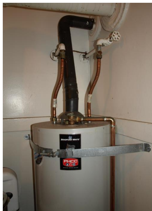
איור 6.4.2.4-4 – שימוש ברצועה לעיגון דוד מים בפינה, מחברי הצינורות גמישים מנחשת.
