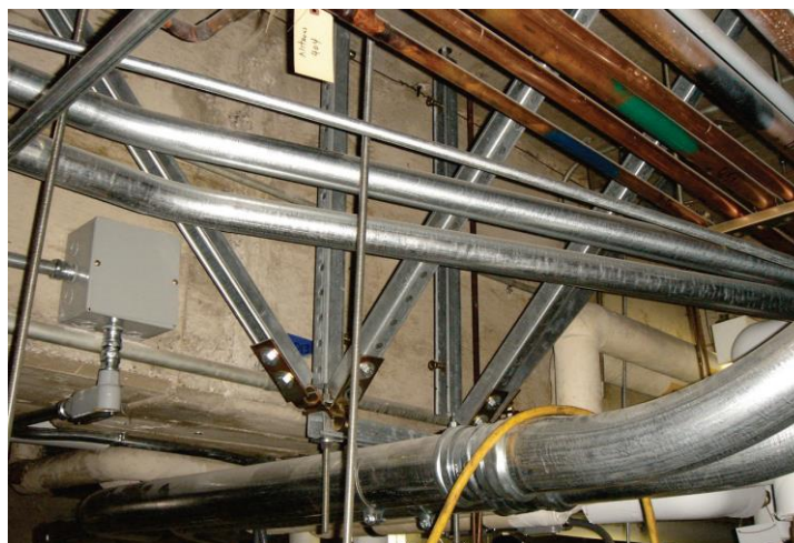
איור 3-6.4.8.1 – תמיכה אלכסונית קשיחה המחברת למסגרת התומכת צנרת חשמל. הצנרת מחוברת למסגרת באמצעות חבקים המספקים עיגון בכיוון האורכי והניצב.
