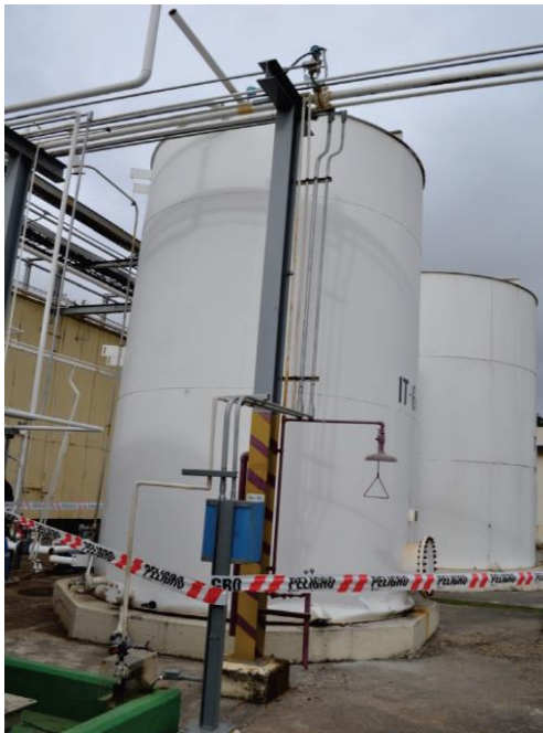
איור 3-6.4.5.1 – נזק למיכלי דלק שעוגנו באופן לקוי שגרם לפגיעה בקווי אספקת הדלק. תמונת התקריב מציגה כשל בצינור באזור מחבר מרותך (משמאל) ומקטע צינור עם שסתום מחובר (בחזית) שנתלש מתוך המיכל.
