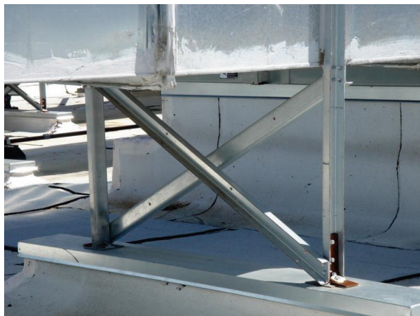
איור 6-6.4.6.1 – תעלה מלבנית המחוברת לגג ונתמכת על ידי מבנה פלדה ייעודי.
