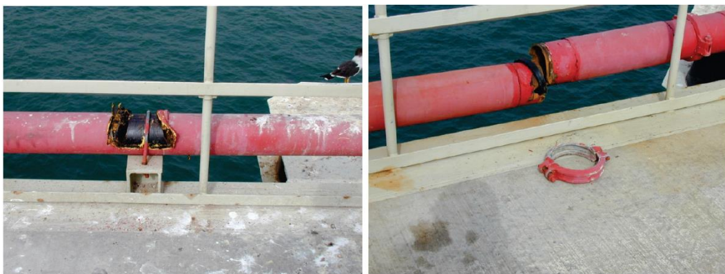
איור 6-6.4.4.1 – דק לצנרת כיבוי אש תעשייתית. מצד ימין – כשל במחבר להצמדת צינורות ומעיכת הצנרת; מצד שמאל – החלקה בכיוון האורכי במחבר U הנותר שלם, אך המחברים האחרים נשברו ונפלו.
