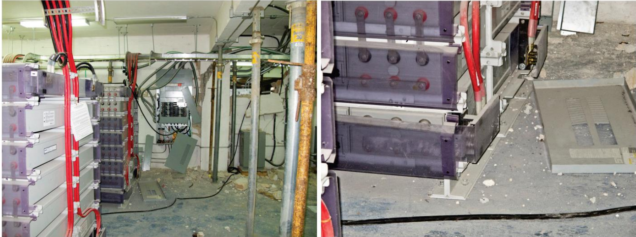
איור 6.4.7.3-6 – חדר סוללות במתקן רשת סלולרית לאחר רעידת אדמה. המבנה בן שלוש הקומות ניזוק מאוד ברעידה ועבר הריסה ובנייה מחדש. שימו לב לעיגון הקשיח של הסוללות המאסיביות שלא נפגעו תפקודית במהלך הרעידה, על אף שהמבנה ספג הזזות גדולות שגרמו לגזירת העמודים התומכים.
