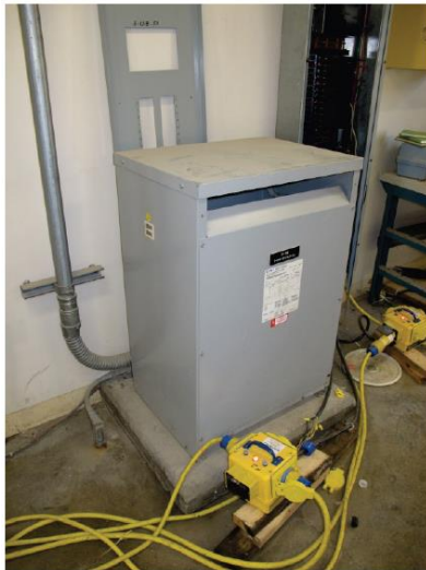
איור 2-6.4.7.3 – שנאי מפצל יבש טיפוס. שימו לב לעיגוני הבסיס שיוצרו כחלק מהמתקן. התמונה צולמה לאחר רעידת אדמה.
