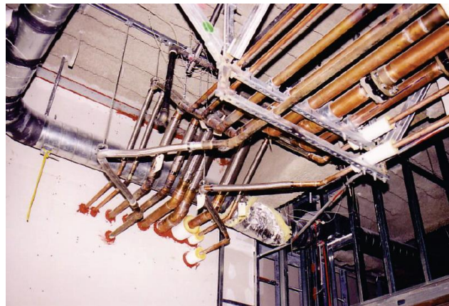
איור 6.4.3.8-4 – צנרת חודרת קיר בחזית עם עיגון צידי, מהדקים גמישים עם תמיכות אנכיות עצמאיות ואיטום החדירה בקיר.
