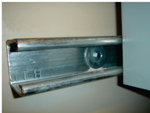
איור 2-6.4.8 – לוח חשמל המעוגן לקיר. הלוח מחובר לאלמנט פלדה תומך אשר מחובר לקיר.
