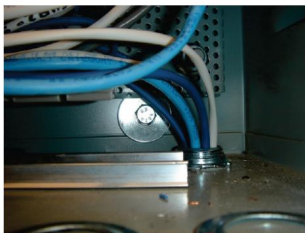
איור 2-6.4.8 – לוח חשמל המעוגן לקיר. הלוח מחובר לאלמנט פלדה תומך אשר מחובר לקיר.
