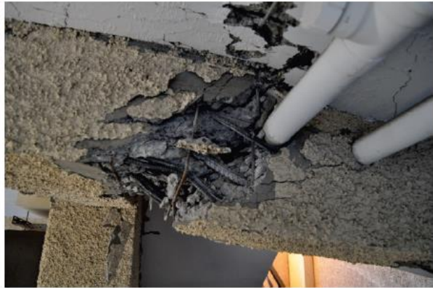
איור 2-6.4.5.2 – שבר בצנרת נחושת להעברת מים חמים. המתלה המוצג לא מעוגן בצדדים, אך מתלים קצרים באורכם (פחות מ-30 ס"מ) לא בהכרח נדרשים לעיגון צדדי בהתאם לתקן ASCE 7-10.
