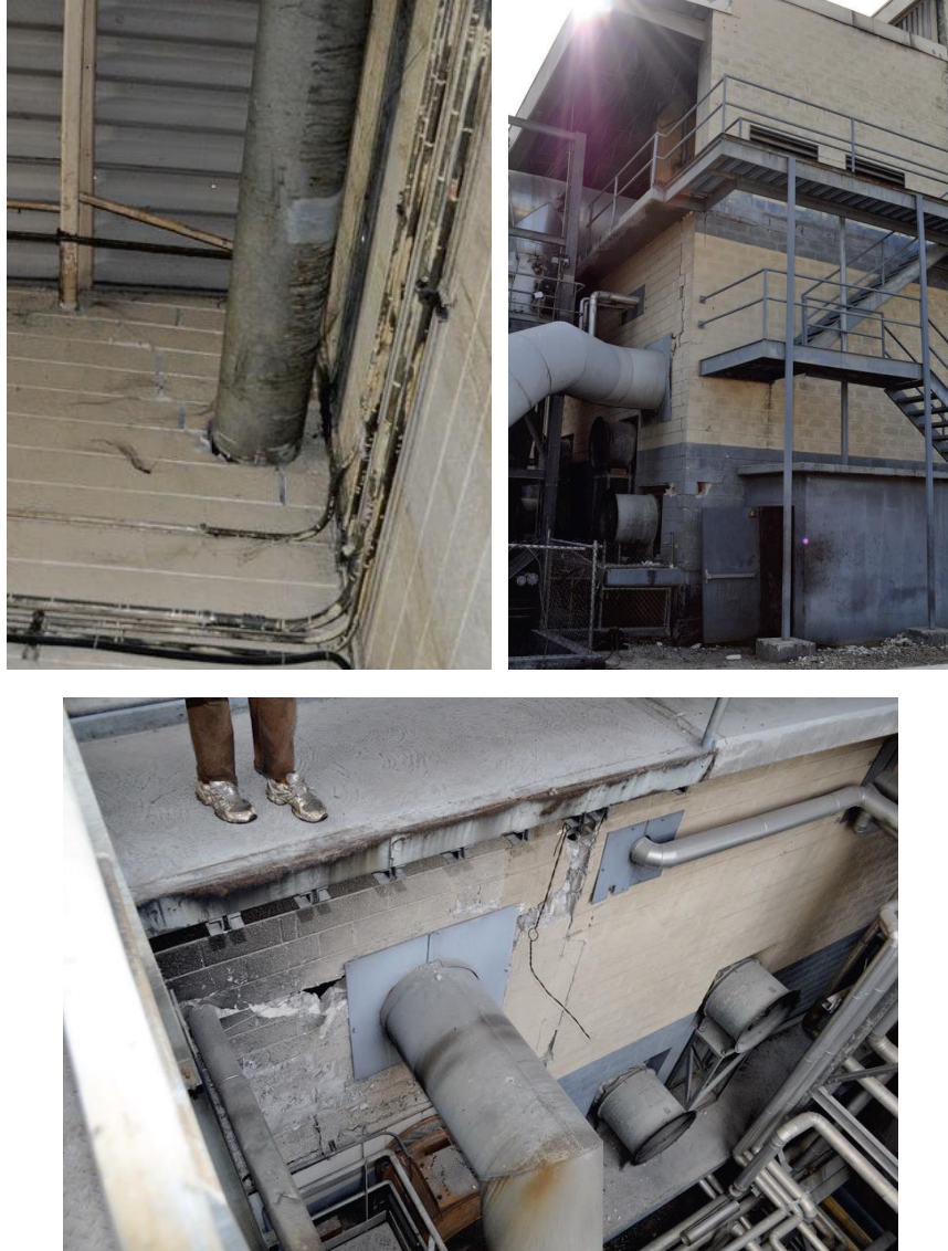
איור 3-6.4.3.8 – צנרת ותעלות חודרות קיר גרמו לפגיעה בקירות בלוקים לא מזויינים במפעל תעשייתי. הצנרת והתעלות לא נפגעו, אך הקיר ניזוק ונדרש לעבור תיקון.
