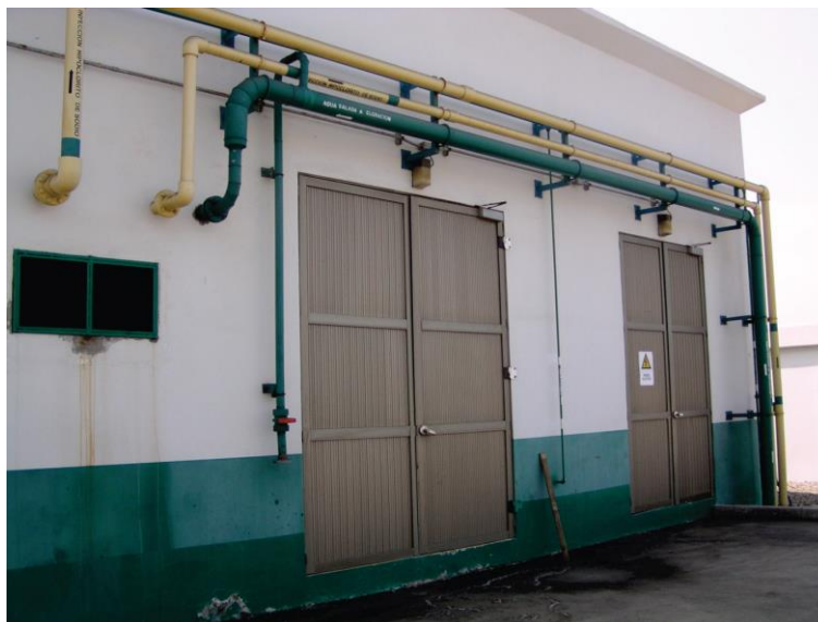
איור 6.4.3.7-1 – עיגון צנרת אופקית ואנכית לקיר חיצוני. ניתן לראות כי נוצר נזק קל לצנרת היורקה החודרת לקיר וכי המחברים הוסטו קלות, אך העיגון תפקד טוב באופן כללי.
