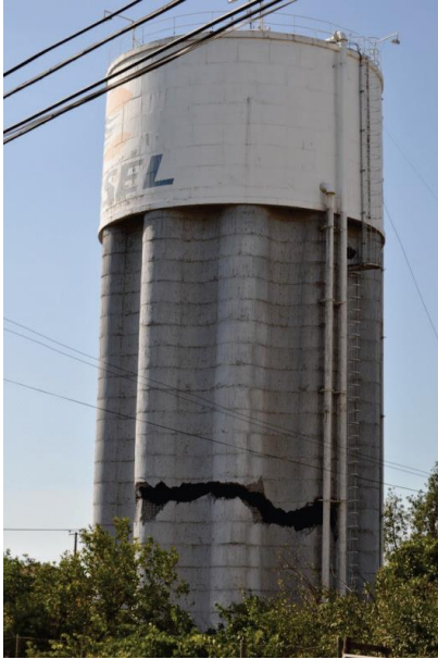
איור 2-6.4.3.7 – עיגון צנרת לקיר סילו ניזוק. למרות הנזק המבני שנגרם לסילו, עיגון הצנרת היצוק באתר נותר שלם והצינורות לא נפלו.
