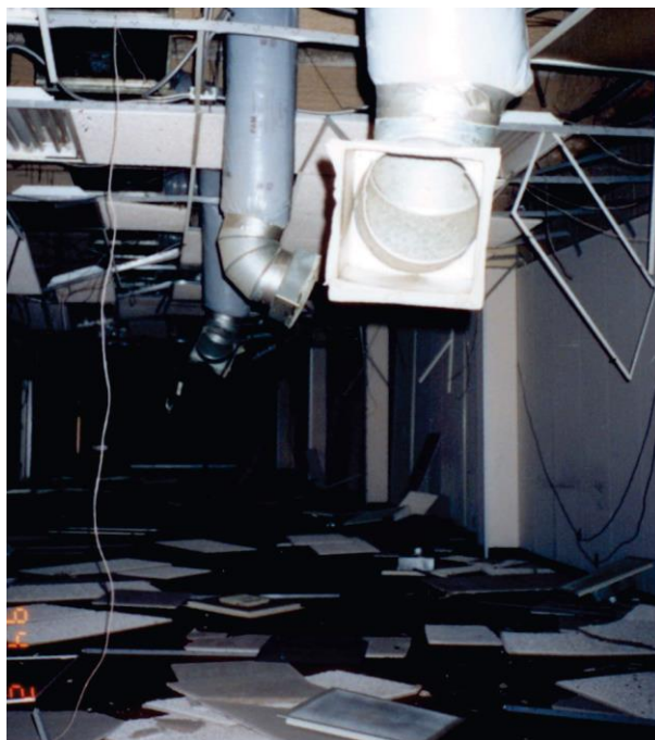
איור 6.4.6.2-1 – מפזרי אוויר שנפלו מהתקרה; תעלות תלויות שהשתחררו מרשת התקרה.
