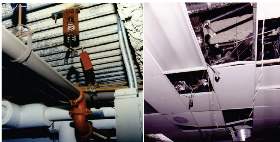
איור 3-6.4.4.1 – נזק שנגרם לצנרת כיבוי אש תלויה. מצד ימין – כשל במהדקי C שלא הכילו רצועות עיגון לקורות; מצד שמאל - כשל במבודד ויברציה.
