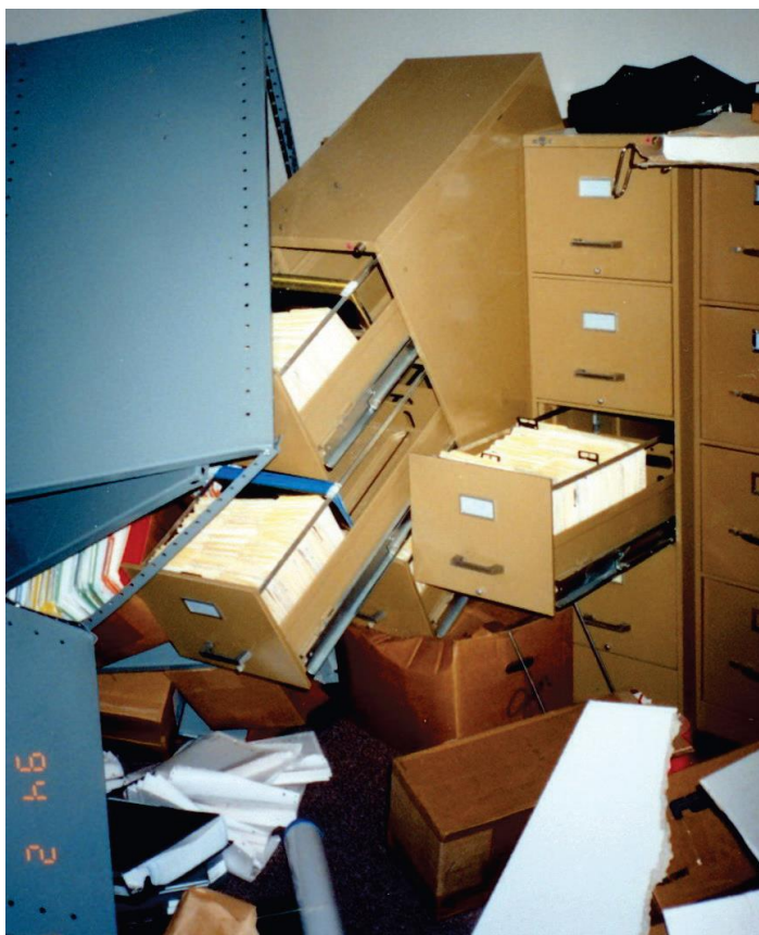
איור 6.5.5.1-1 – נפילת ארון תיוק עקב רעידת אדמה.
