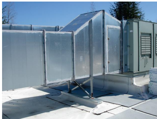
איור 6-6.4.6.1 – תעלה מלבנית המחוברת לגג ונתמכת על ידי מבנה פלדה ייעודי.
