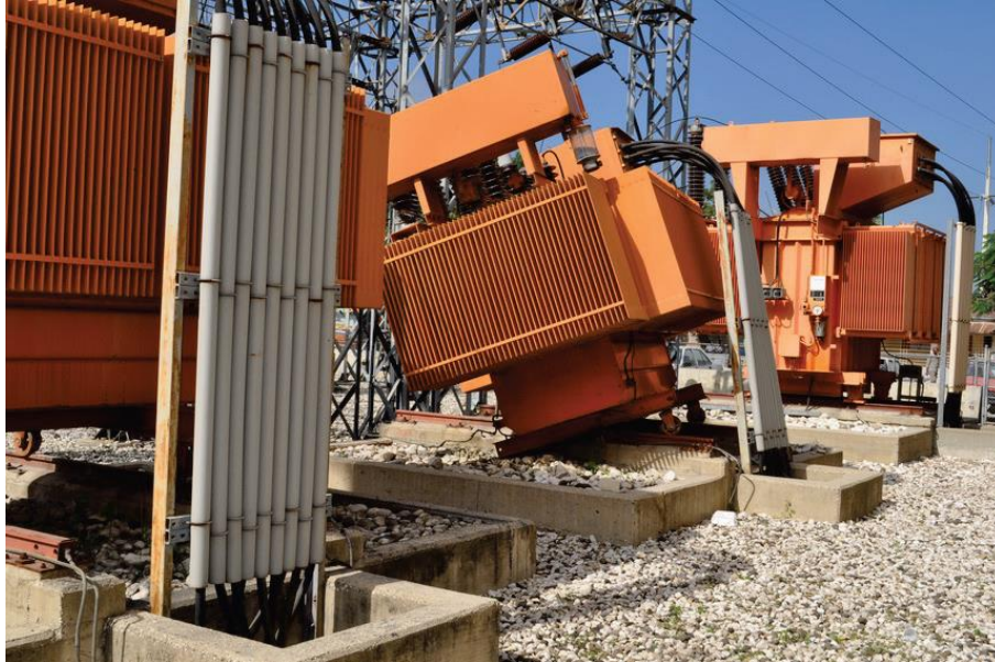
איור 1-6.4.7.3 – שנאי בתחנת כוח שהחליק מהמסילה עליה הותקן. נזק נגרם לשנאי אחד בלבד מתוך שישה שנאים זהים בתחנה.
