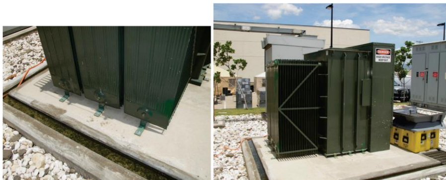
איור 6.4.7.3-5 – שני שמן חיצוני הממיר מתח עבור מתקן חשוב. שימו לב לרכיבים האלכסוניים על המצנן במטרה למזער את ההעמסה הדינאמית על מיכל הנזולים המכיל מספר חיבורים מרותכים.
