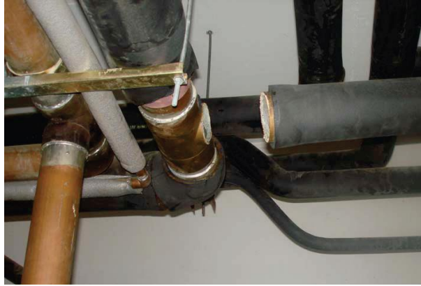
איור 2-6.4.5.2 – שבר בצנרת נחושת להעברת מים חמים. המתלה המוצג לא מעוגן בצדדים, אך מתלים קצרים באורכם (פחות מ-30 ס"מ) לא בהכרח נדרשים לעיגון צדדי בהתאם לתקן ASCE 7-10.
