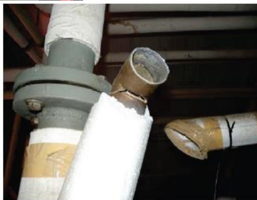
איור 6.4.5.2-1 – שבר בצנרת נחושת להעברת מים חמים. הכשל נגרם עקב תזוזת דוד החימום המוצג מצד שמאל.
